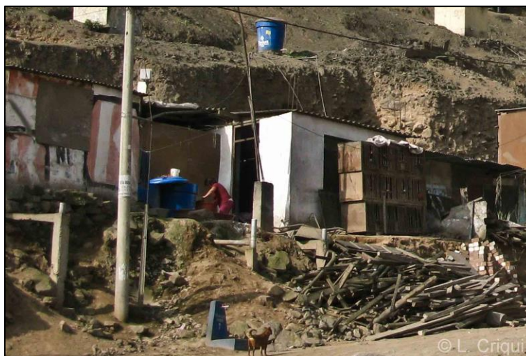
Figura 6: Pileta pública, tanque domiciliario para cocina y tanque sur-elevado y mangueras para limpieza
