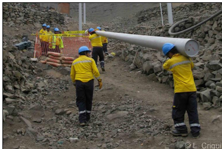
Figura 5: Instalación de postes de fibra de vidrio en asentamientos remotos sin maquina
